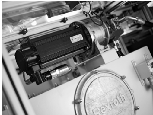
Şekil 2. Değişken devirli pompa tahrik sisteminin kullanıldığı hidrolik güç ünitesi
